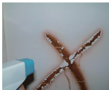
②洗剤 吹付け
